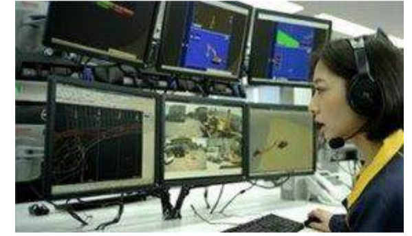
遠隔操作などの オペレーションセンター
